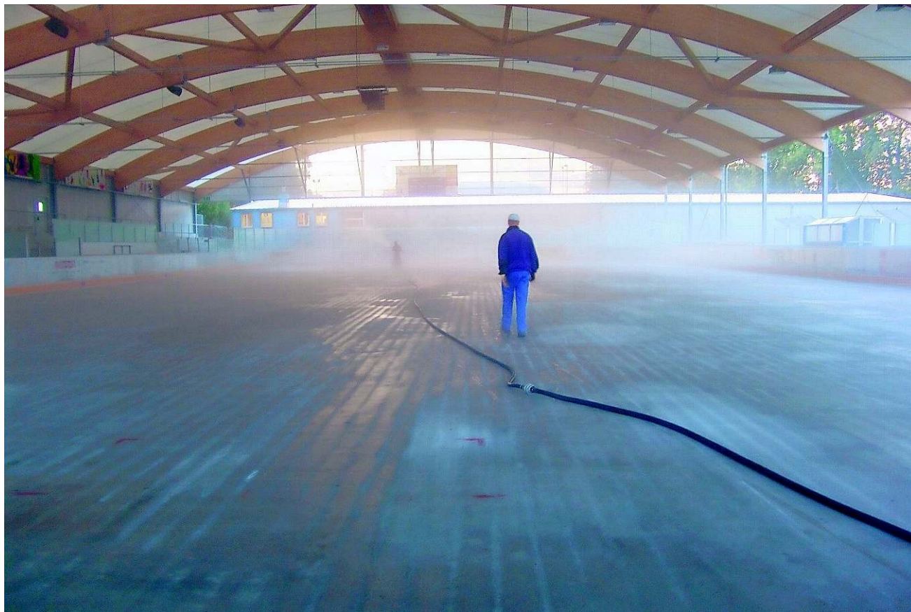
Arbeiter tragen eine ein Millimeter dicke Eisschicht auf, damit die Kälteplatte sich nicht aufwärmt.
